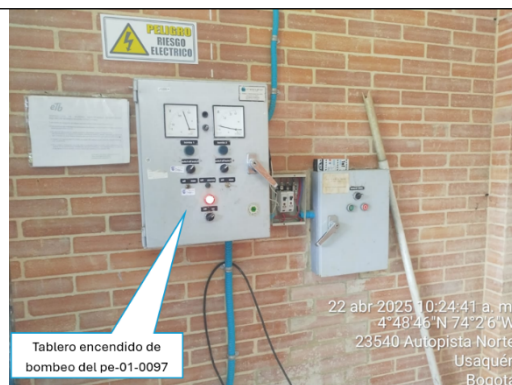
Foto No. 10. Tablero encendido de bombeo del pozo pe-01-0097
