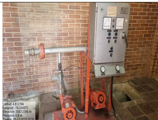
Foto No. 4. Sistema de extracción deshabilitado
