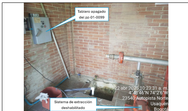
Foto No. 14. Tablero apagado y sistema de extracción deshabilitado del pozo pz-01-0099
